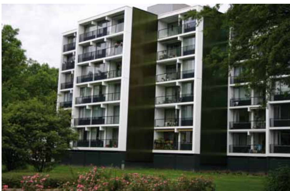
Ook de balkons werden aangepakt met nieuwe vloeren, balustraden en glaswanden.
